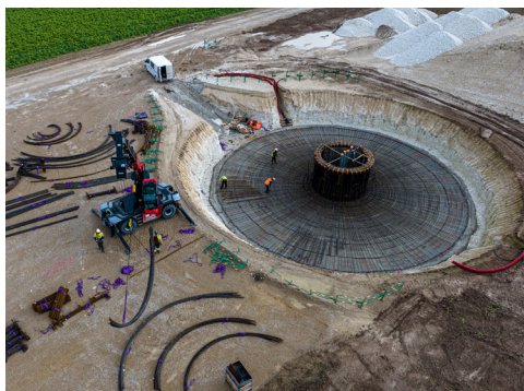
Le ferrailage est fait de 67 tonnes d'armatures en acier.
