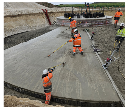
Environ 1 500 tonne de béton est coulé au travers du ferrailage. Temps de séchage : 28 jours
